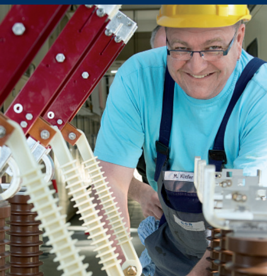
Wartung eines Last-Trennschalters
