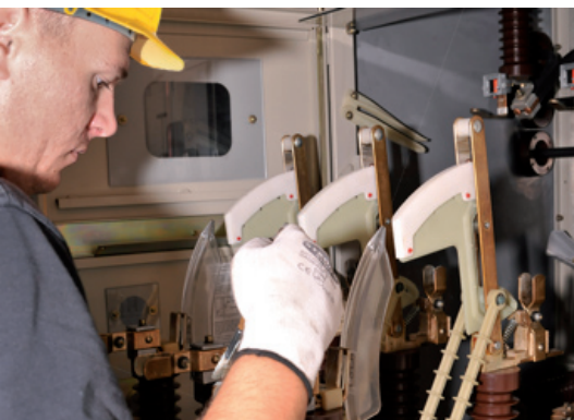
Wartung eines Last-Trennschalters
